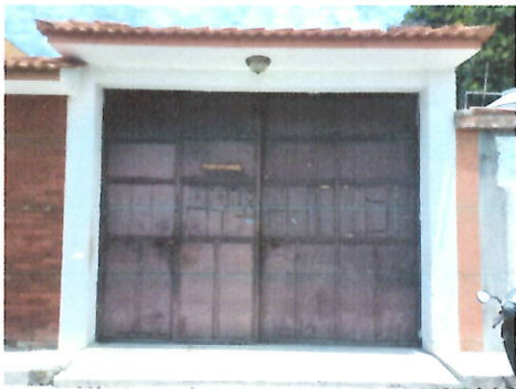
Foto 6: mantenimiento a portón de ingreso, material: metálico, incluye: bisagras y sistemas de cierre.
