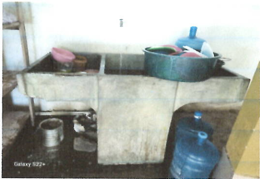
Foto 10: Sustitución pila, nivelada y con conexiones hidráulicas.
