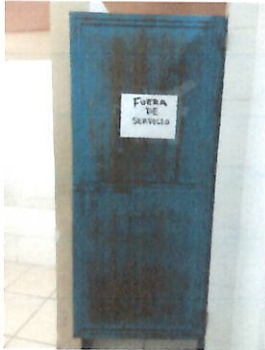
Foto 2: Mantenimiento a puerta metálica existente retiro de óxido, suciedad y pintura deteriorada; incluye cepillado, lijado y aplicación de pintura
