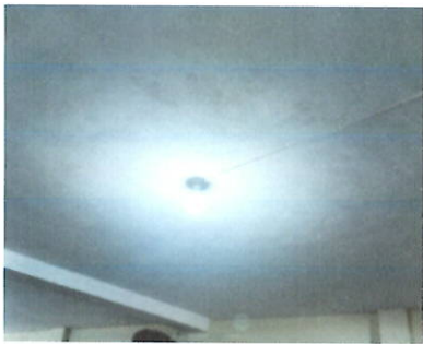
Foto 9: Sustitución de sistemas de iluminación: Lámparas
