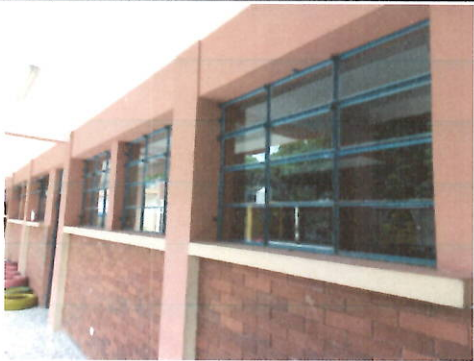
Foto 3: Sustitución de ventanas; sistema de apertura: Corredizas, Perfiles color blanco estandar, Material del marco: PVC Material de la ventana: Vidrio, sellado perimetral.
