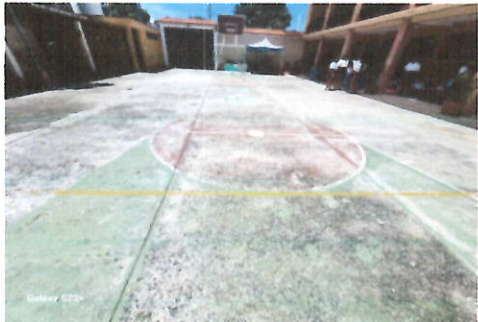
Foto 7:Preparación de la superficie y aplicación de pintura en cancha polideportiva.
