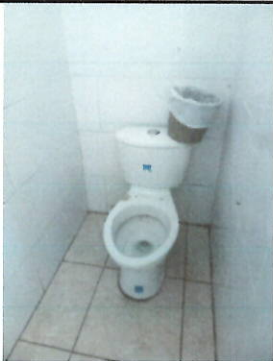
Foto 4: Sustitución de accesorios de sanitarios, incluye accesorios internos, externos, tapa y asiento.
