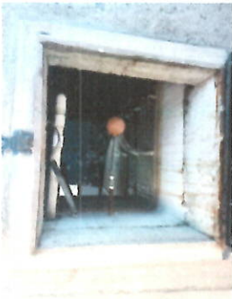
Foto 5:Sustitución de accesorios de tanque de almacenamiento de agua.
