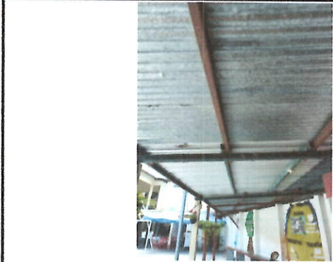
Foto1: Sustitución de cubierta de techo con lámina galvanizada, Tipo de lamina: troquelada Calibre: 26, incluye: fijaciones y sellado en traslapes en área recreativa y comedor.
